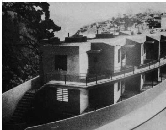
Figura 2: Apartamentos Proletários na Gamboa – fotografia da obra recém-construída
